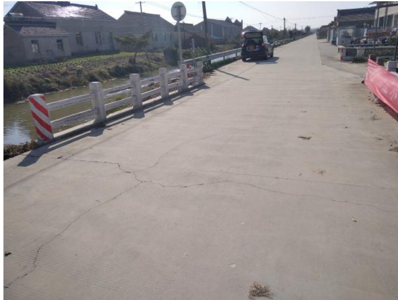
方腰线十二号沟桥现状图
